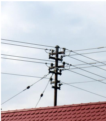
Franz Josef Sauer musste auf eigene Kosten Dachständer usw. für die Stromversorgung installieren lassen
