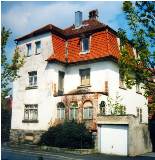
In diesem Gebäude, Grabenstr. 8 in Arnstein, waren 1945 Teile der amerikansichen Militärregierung untergebracht
