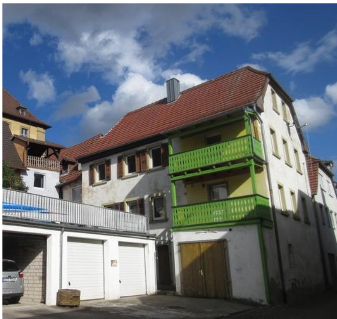
Das Gebäude in der Goldgasse wie es Johann Fischer errichtete
