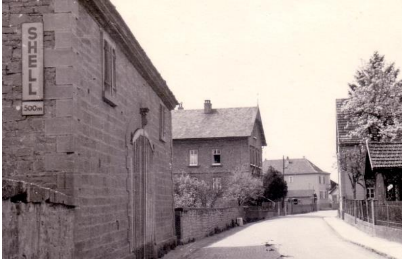
Die Grabenstraße mit der Scheune der Mühlenanwesens Laudensack (Foto Karl Michael Fischer)
