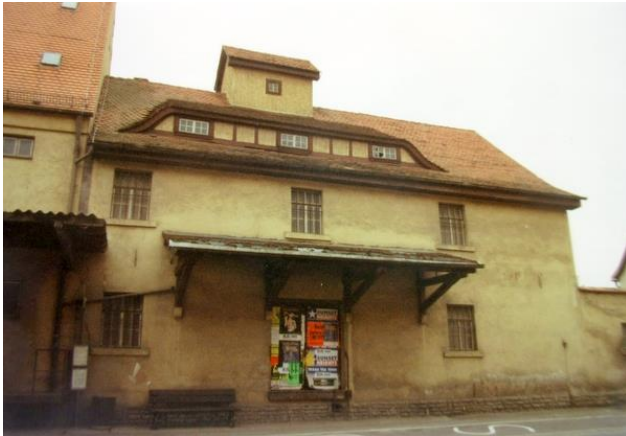
Das alte BayWa-Gebäude in der Grabenstraße
