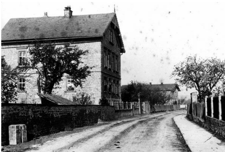
Das Haus Grabenstr. 3
