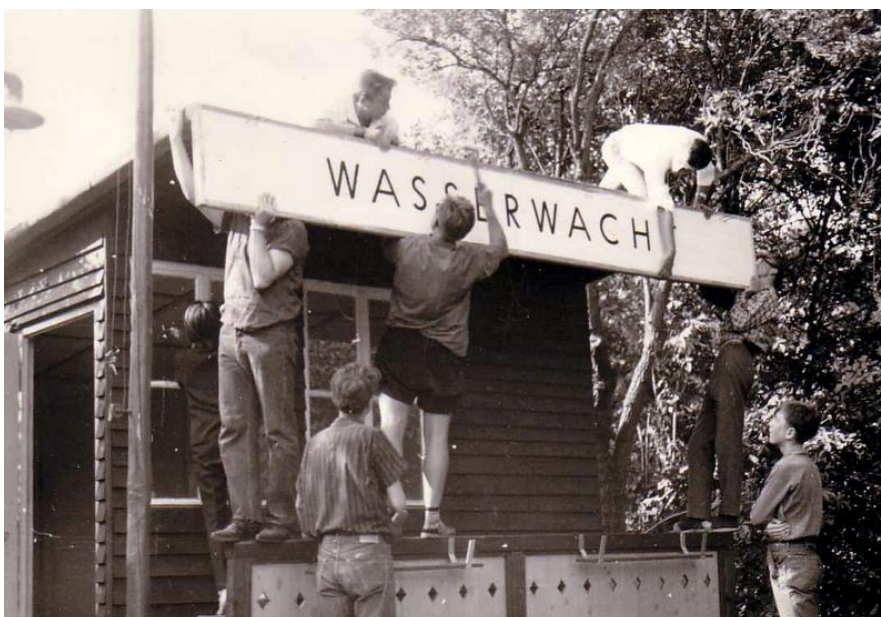
Bau der Hütte Anfang 1962
