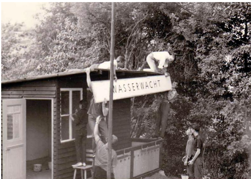
Weiteres Foto vom Hüttenbau
