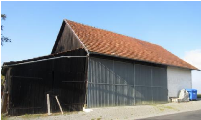
Die Scheune am Ortseingang von Dürrhof im Oktober 2016
