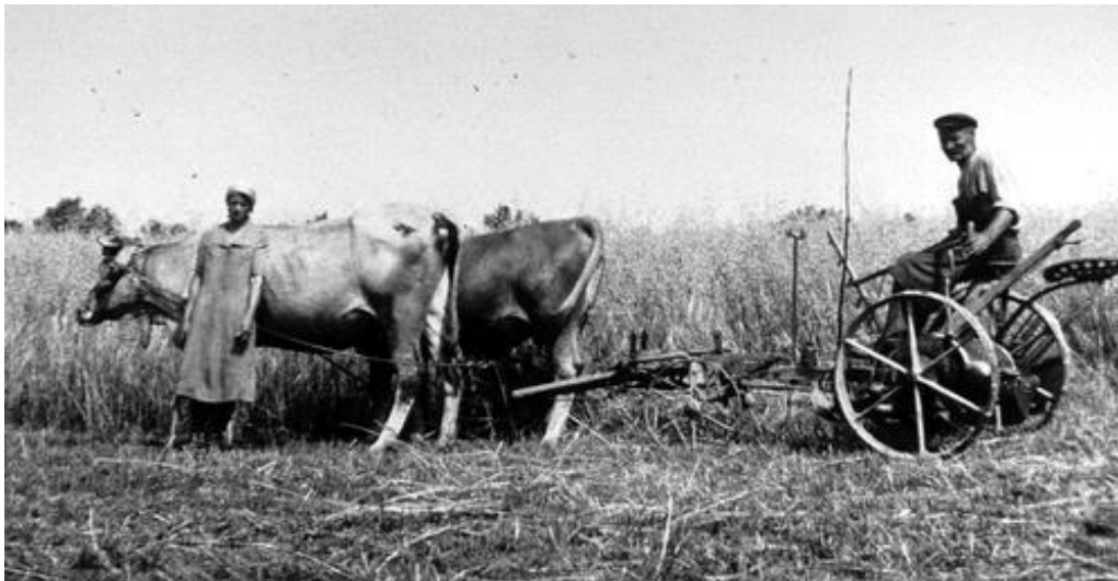
Die die Knechte im Felde kämpfen mussten, wurden Fremdarbeiter eingesetzt
