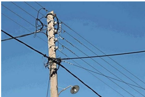
Nachdem man damals noch oberirdische Leitungen hatte, war der Anschluss nicht zu teuer
