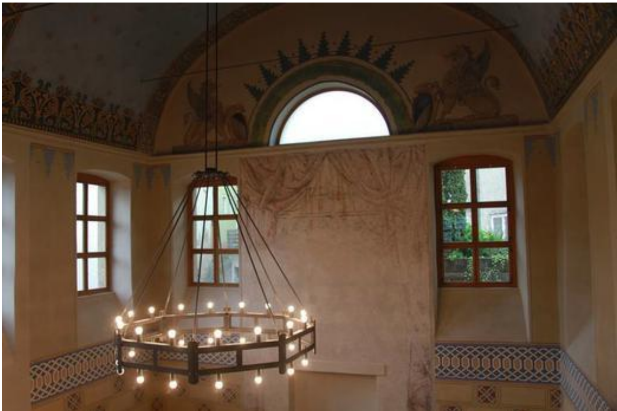
Die Arnsteiner Synagoge nach der Renovierung
