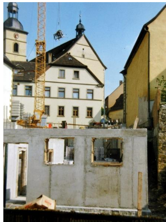
Baustelle von Westen gesehen
