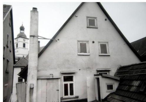
Rückseite des Gebäudes
