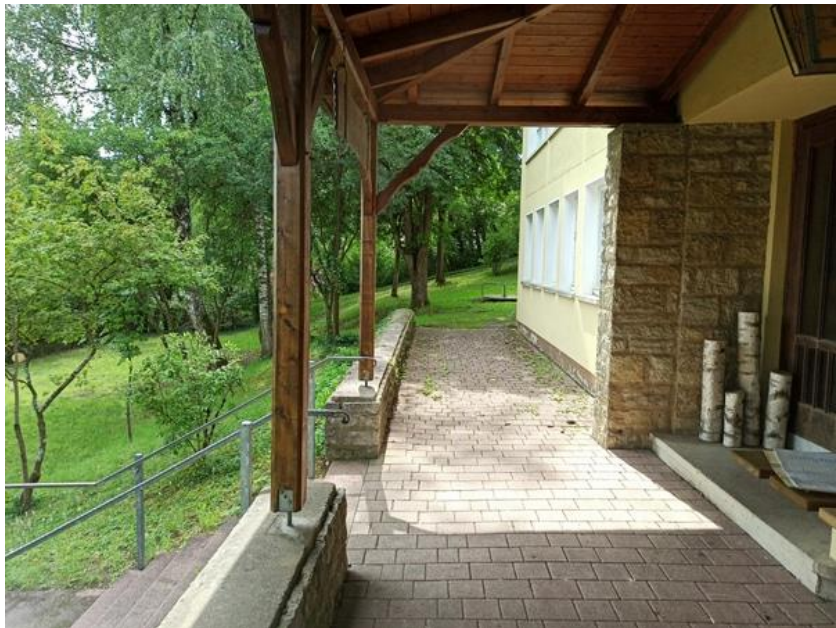
Die Firma Baheco übernahm die Pflasterarbeiten im Eingangsbereich (Foto Markus Volk)
