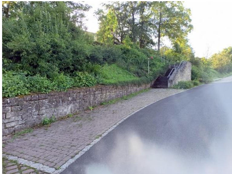
Die Straße unterhalb des Vereinsheims wurde neu asphaltiert (Foto Markus Volk)
