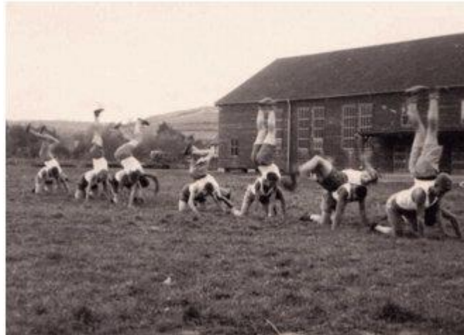
Bockspringen vor der neu erbauten Turnhalle
