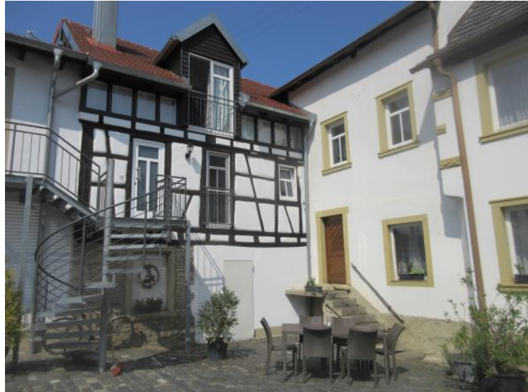
Bergmühle heute, Innenhof
